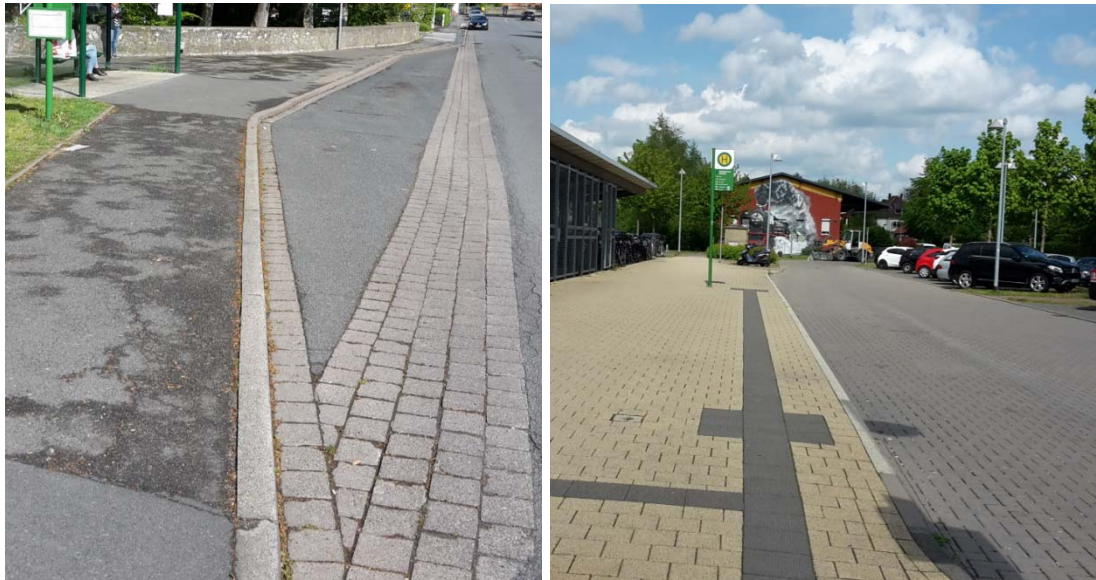
Abbildung 20: links: Busbucht mit zu kurzer Ausbildung ermöglichen kein spaltfreies Anfahren der Haltestellenkante (Beispiel: Bockenem Thornburyplatz); rechts: Aufpflasterungen bergen das Risiko der Spurrillenbildung (kein dauerhaft spaltfreies Anfahren der Haltestellenkante) (Beispiel: Nordstemmen Bahnhof)
